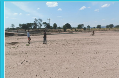
Picha Nn.3 - Mwanachama wa rafu Kikungu barabara ya Shabul - Mkoa - Ndago kabla ya kuanza ujenzi wa kawaali la zage
