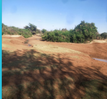
Mwonekano wa barabara ya Mwangeza-kipamba kabla ya matengenezo
