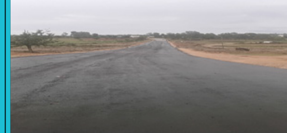
Barabara ya mjiini longoro kwa kwanzo cha lami (Double Surface Dressing)
